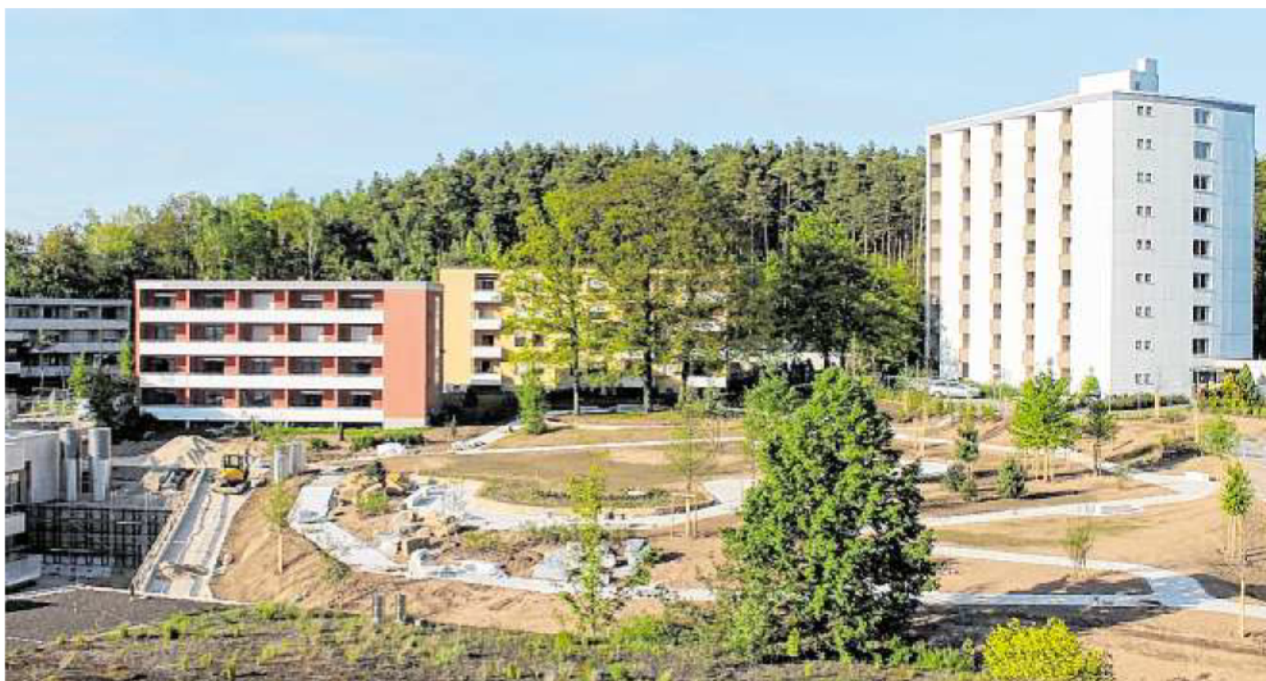
Das Gelände nahe des Green Hospital mit Schwesternwohnheim (re.) und weiteren Gebäuden: Hier soll ein neues Baugebiet für Ein- und Mehrfamilienhäusern entstehen. Die Gebäude sollen abgerissen werden. FOTO: ROGER MARTIN
